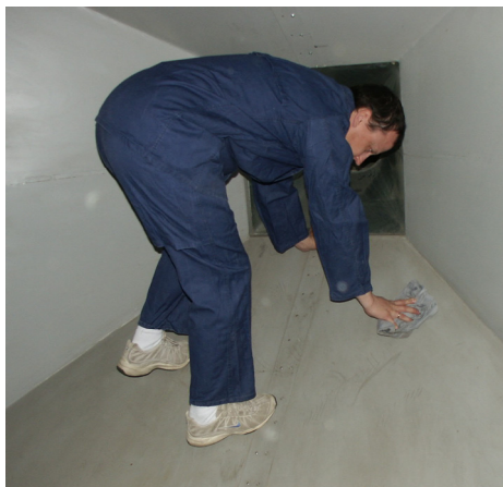
Fot. 3. Wcieranie środka konserwacyjnego w powierzchnię podłogi – 1
