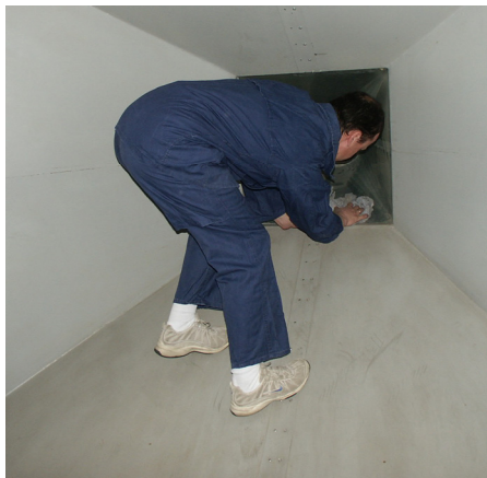
Fot. 2. Czyszczenie środkiem konserwującym w kanale wentylacyjnym
