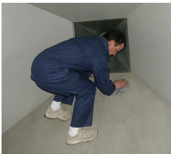
Fot. 4. Wcieranie środka konserwacyjnego w powierzchnię podłogi – 2
